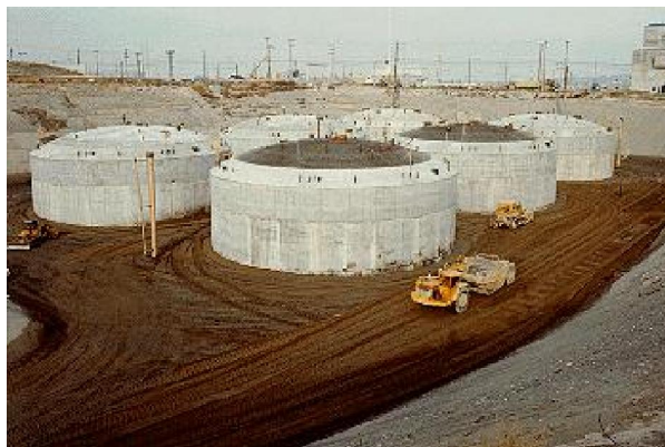
شکل ۱- مخزن های مورد استفاده برای ذخیره زباله سطح بالای مایع در سایت هانفورد در آمریکا
