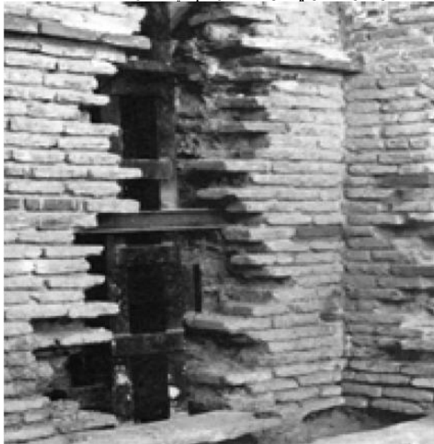
شکل ۱- استفاده از سازه جدید در دل سازه قدیمی
