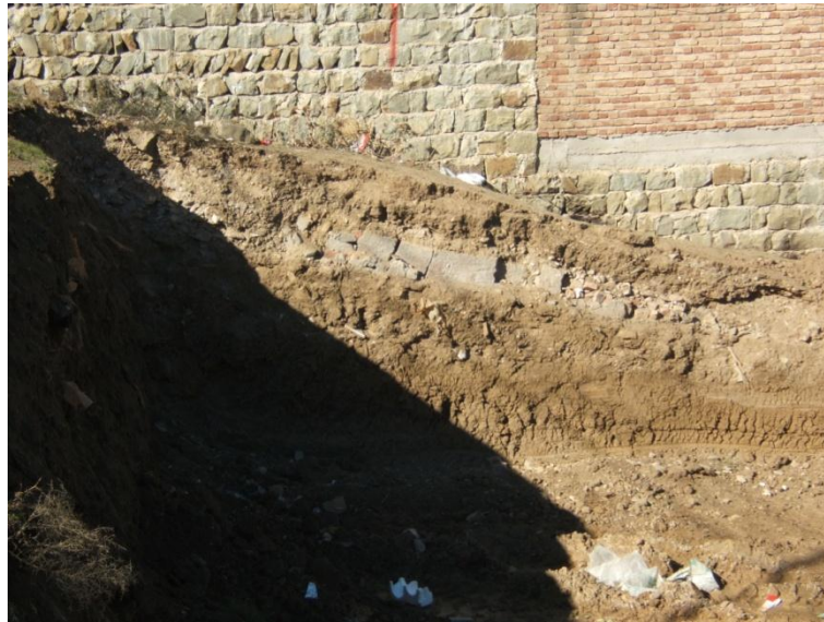
شکل ۲- سنگ‌های رسی در پی ساختمان‌های احداث شده قبلی و در محل احداث ساختمان جدید
