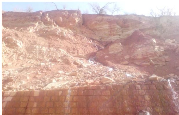
شکل ۷- ترانشه سنگی ایستگاه هشتم (دید به شرق)
