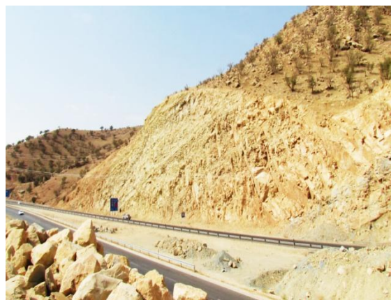
شکل ۳- ترانشه سنگی ایستگاه اول (دید به غرب)
