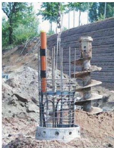
شکل ۱- نمونه ای اجرا شده از شمعهای ژئوترمال
