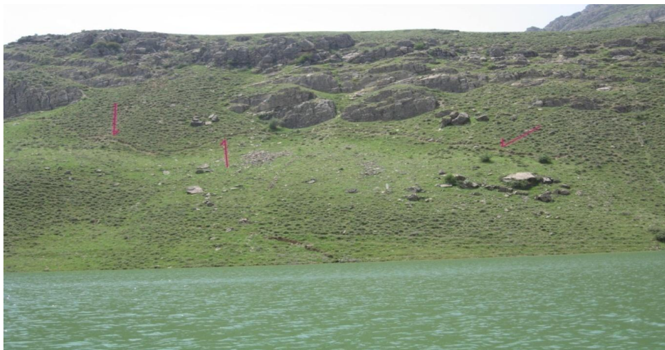
شکل (4): ترک‌های کششی ایجاد شده در سطح توده که به طرف عمق گسترش دارد
