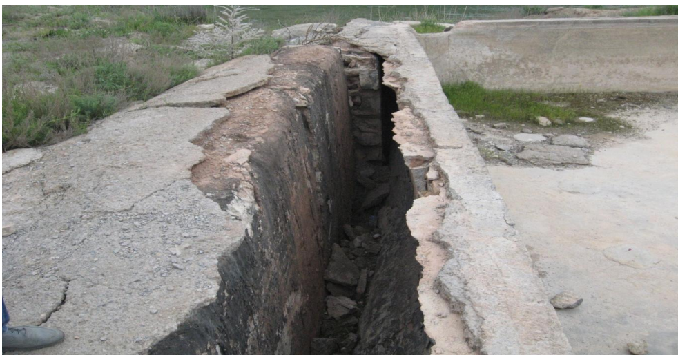
شکل (5): ترک‌های ایجاد شده در اطراف استخر بتنی واقع بر روی دامنه مذکور
