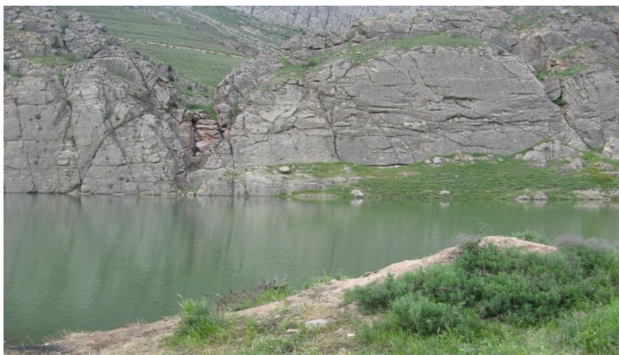
شکل (8): نمایی از سیستم درزه های بخش جنوبی مخزن سد زاوین
