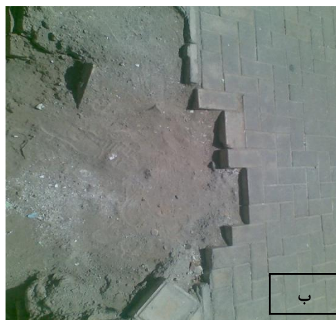
شکل (۴)- نمونه ای از خرابیهای برداشت شده از پیاده روهای محدوده مشخص شده
